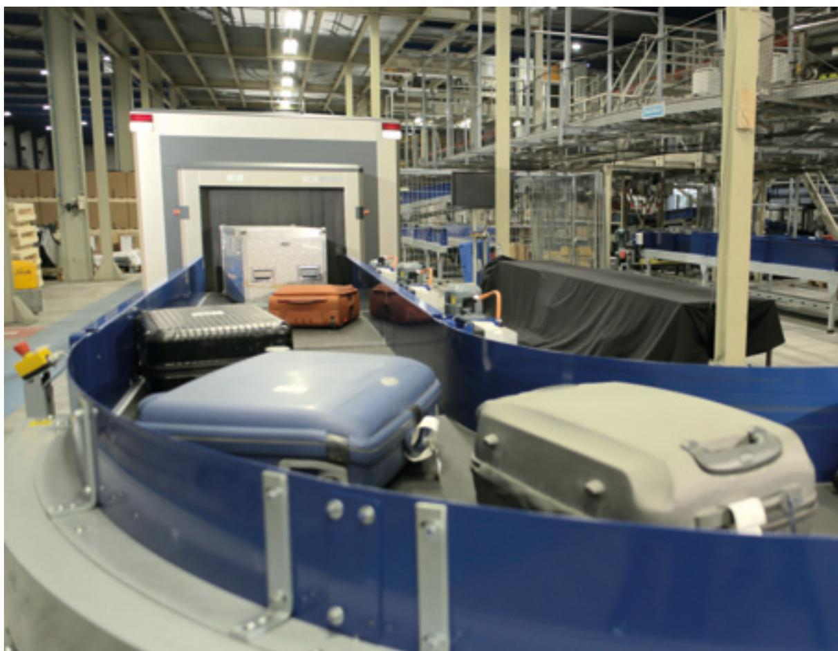
Röntgenprüfsystem HS 10080 XCT, integriert in Gepäckförderanlage
